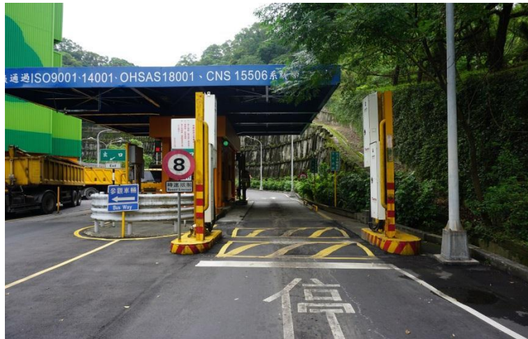
垃圾焚化廠之門框式輻射偵檢器
